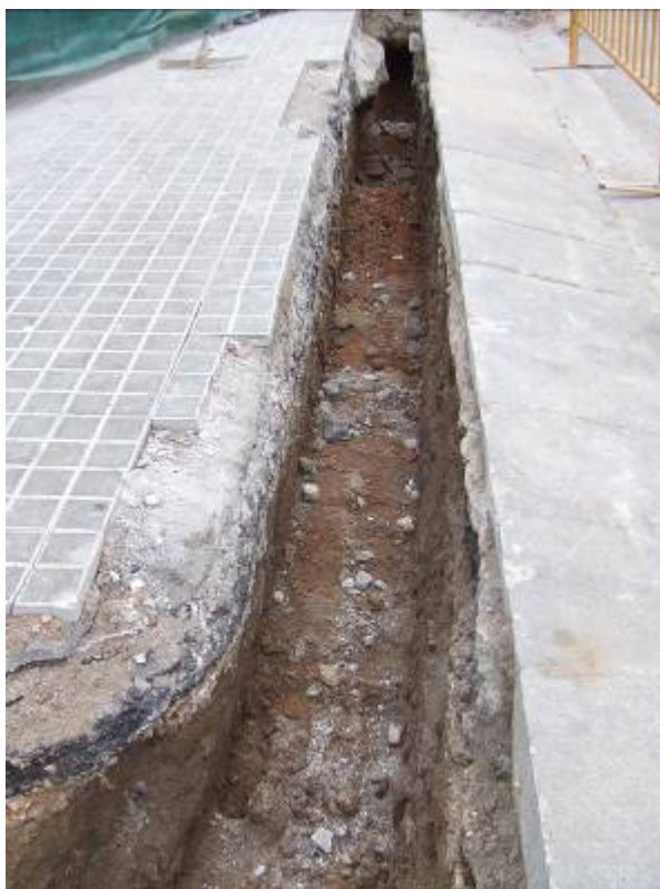
Fotografia núm. 4 vista de la rasa 1000
