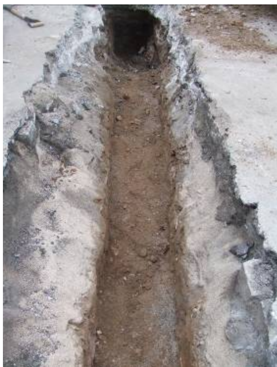
Fotografia núm. 5: vista de la rasa 1000
