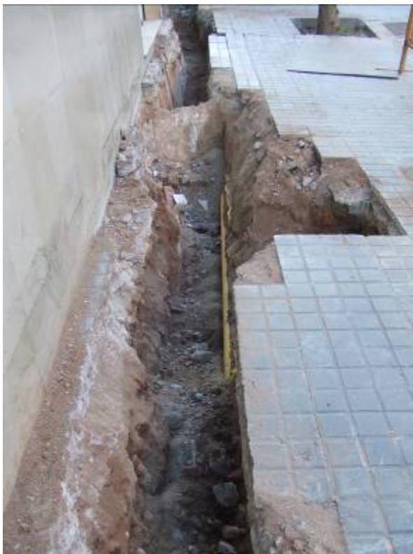
Fotografia núm. 2 vista de la rasa 1000
