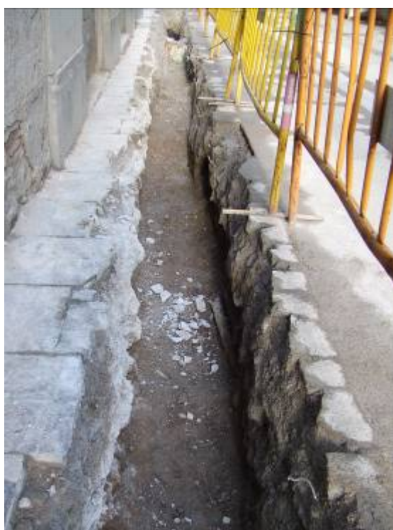
Fotografia núm. 6: vista de la rasa 1000
