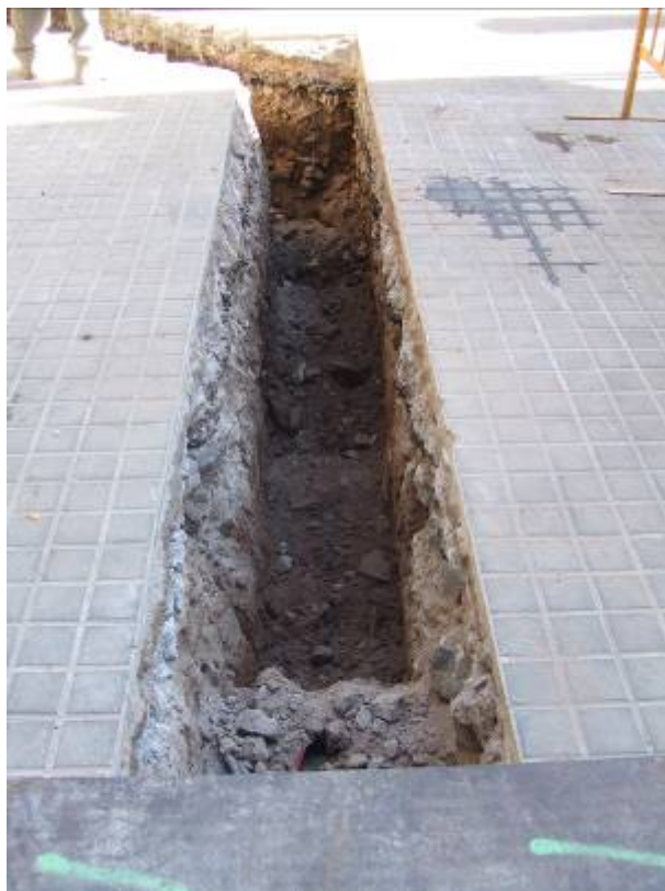
Fotografia núm. 3 vista de la rasa 1000
