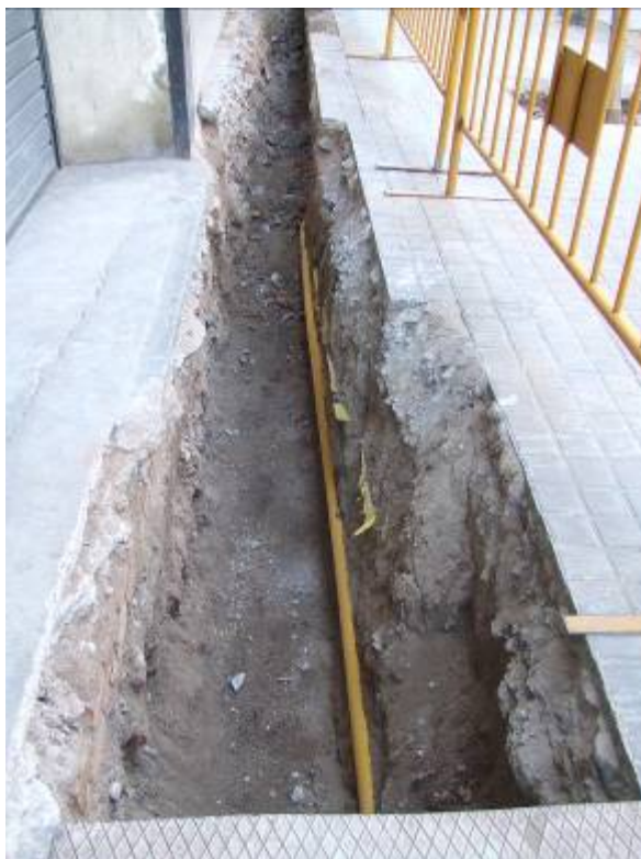
Fotografia núm. 1 vista de la rasa 1000
